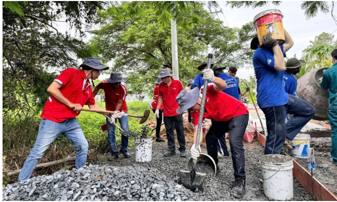
Hình: INSEE đã tham gia xây dựng tuyến đường giao thông nông thôn trong khuôn khổ Chiến dịch Mùa Hè Xanh 2024 tại Tuyến đường số 11, xã Long Thới, huyện Nhà Bè.
