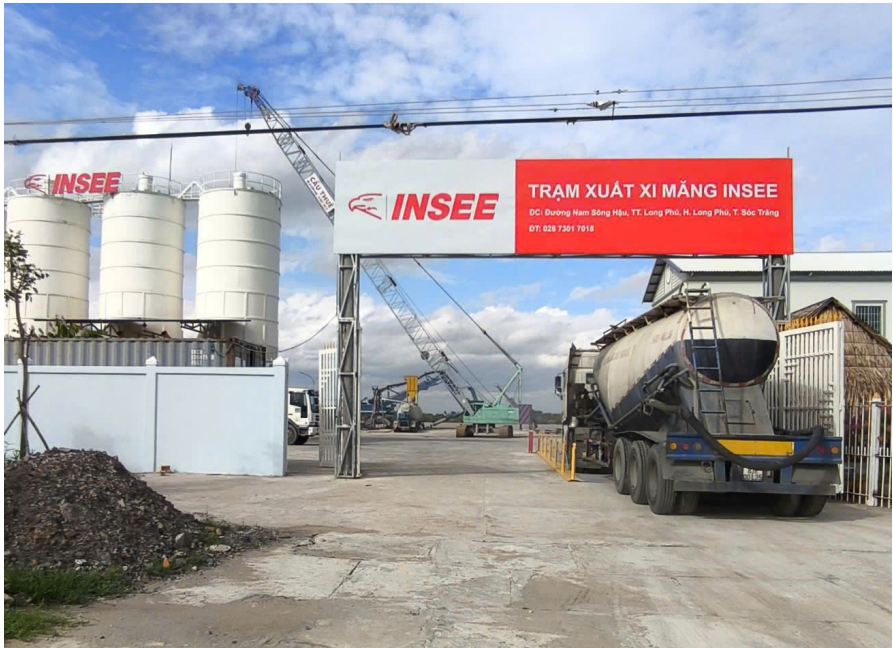
Hình: Trạm xuất xi măng tại Tỉnh Sóc Trăng
